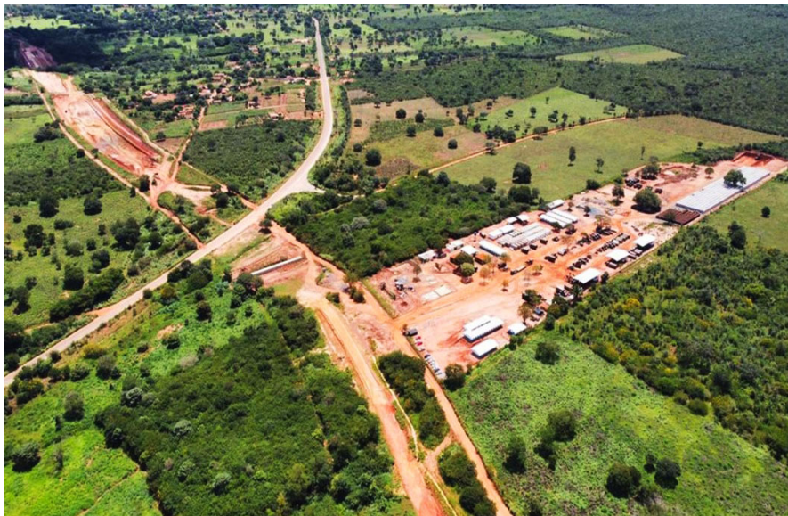
Figura 4.7: Destacamento Guar (canteiro de obras da FIO). Fonte: 4 BEC.
