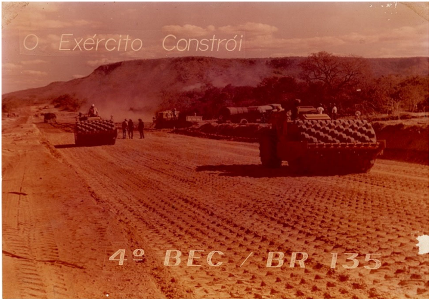
Figura 4.1: obra da BR-135. Fonte: 4º BEC.
