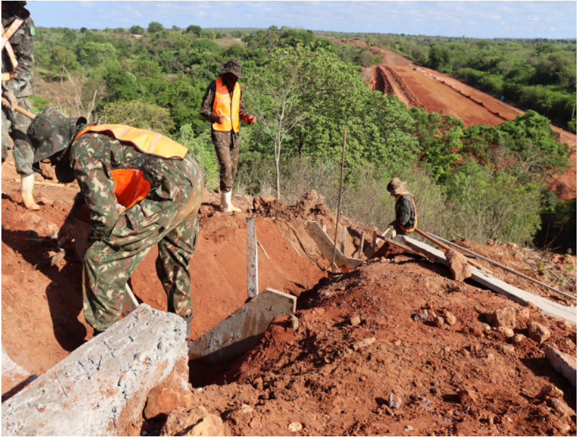
Figura 7.12: soldados preparam valetas no trecho de obras. Fonte: 4º BEC.
