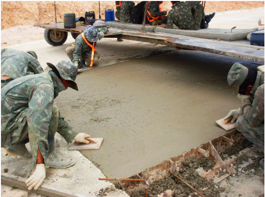
Figura 7.17: soldados lançam placa de concreto no trecho de obras. Fonte: 1º Tenente R/2 Pinheiro.
