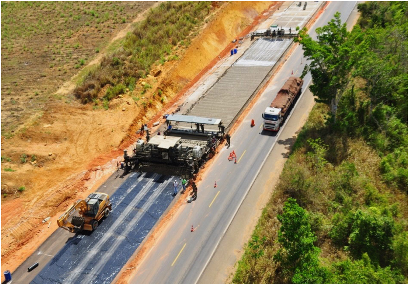
Figura 4.3: duplicação do Lote 2 da BR-101, no Estado de Sergipe. Fonte: 4º BEC.
