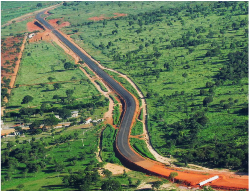
Figura 4.2: obra do Contorno Rodoviário de Barreiras. Fonte: 4º BEC.
