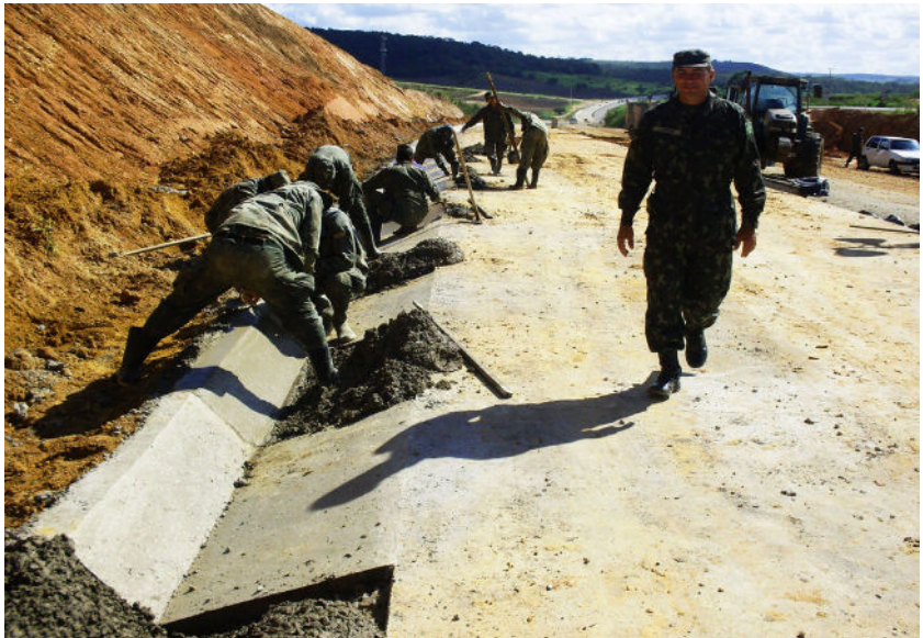
Figura 7.13: soldados recrutas aprendem drenagem no trecho de obras. Fonte: 1º Tenente R/2 Pinheiro
