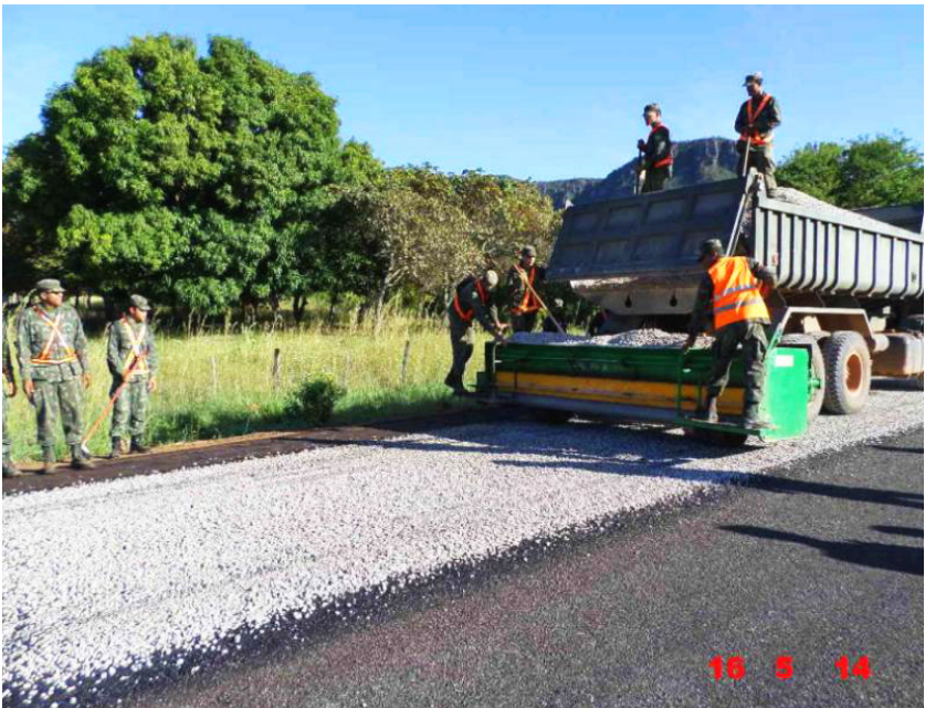
Figura 4.4: restauração das rodovias TO-040 e TO-110. Fonte: 4º BEC.
